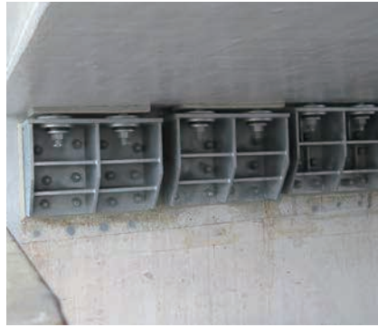
桁下型(鋼製架台2本設置)
