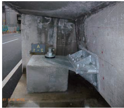
基本型(RC 中空側面設置)
