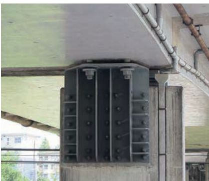
応用型(PC 箱桁設置)
