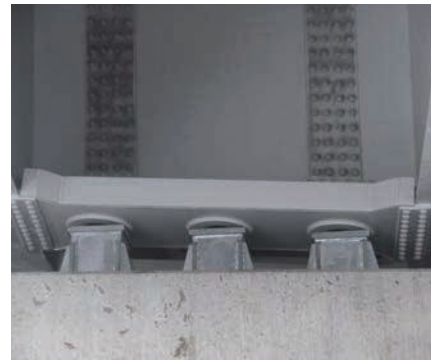
応用型(横梁-鋼製架台)
