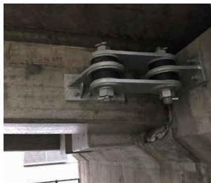
連結型(RC 桁-変位制限構造)
