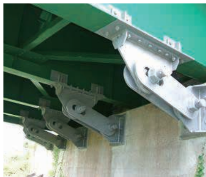
連結型(上部-下部連結、落橋防止)
