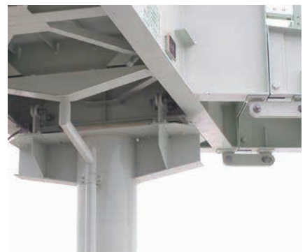
連結型(横断歩道橋、落橋防止)
