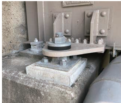
応用型(羽根連結板-PL架台)
