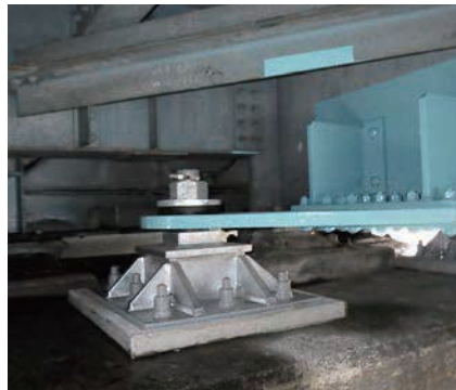
応用型(鉦桁橋桁根連結板-鋼製架台)
