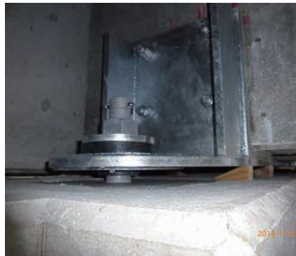
基本型(RC-T桁 縁端拡幅部設置)
