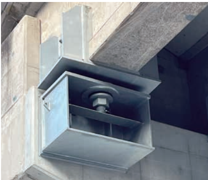
桁下型(RC-T桁設置)
