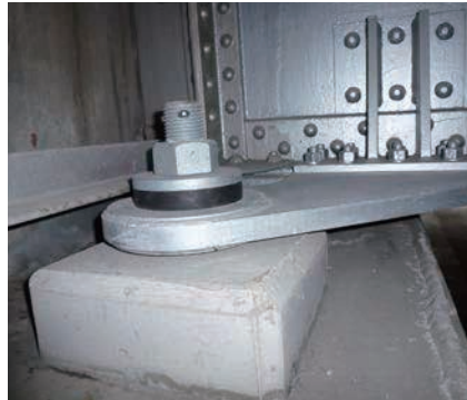
基本型(羽根連結-根巻コンクリート)
