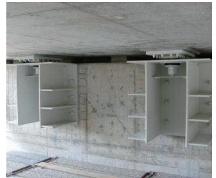
桁下型(Al-Mg溶射、Wナット仕様)
