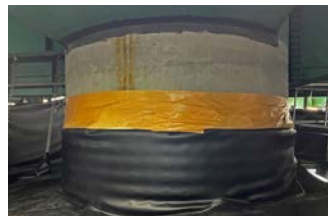
橋脚周り処理
