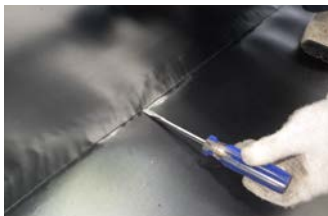
接合部チェック(ドライバー試験)
