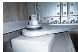
基本型 (羽根連結-根巻コンクリート)
