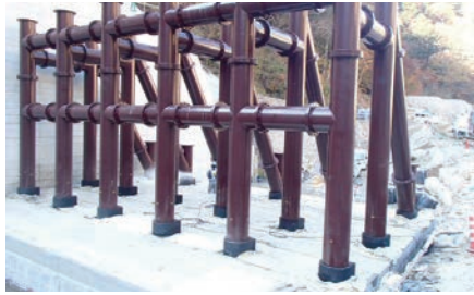
▲中部地方整備局多治見砂防国道事務所 越百川第3号砂防堰堤 (長野県)
