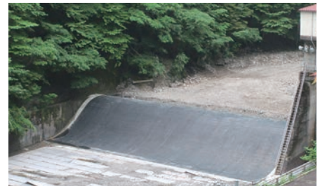
▲近畿地方整備局紀ノ川ダム統合管理事務所 川原樋川取水堰 (奈良県)
