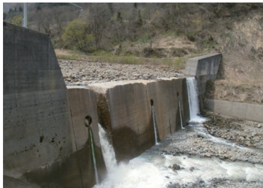
▲ラバースチール設置なし (経過年数10年※コンクリートにて天端補修後最大約10mの摩耗) (位置：右記砂防堰堤の下流)
