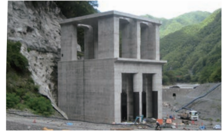
▲中部地方整備局天竜川ダム統合管理事務所 小渋ダムバイパストンネル (長野県)
