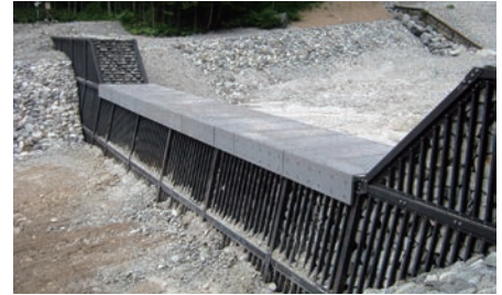
▲北陸地方整備局松本砂防事務所 八衛門沢床固工 (長野県)
