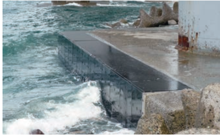
▲東日本高速道路(株)新潟支社 信越工事事務所 親不知海岸高架橋 (新潟県)
