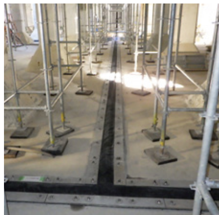
⑥施工完了
