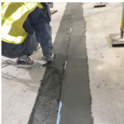
②モルタル工
