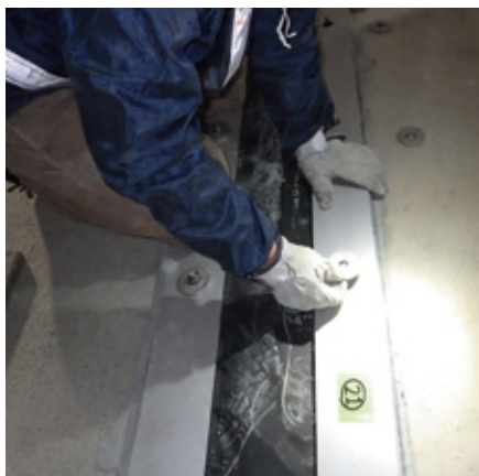
⑤継手設置工
