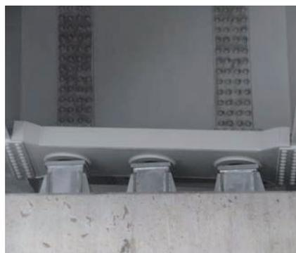
応用型(横梁-鋼製架台)
