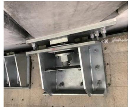
桁下型(PC ホロー桁設置)
