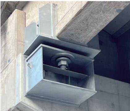
桁下型(RC-T桁設置)
