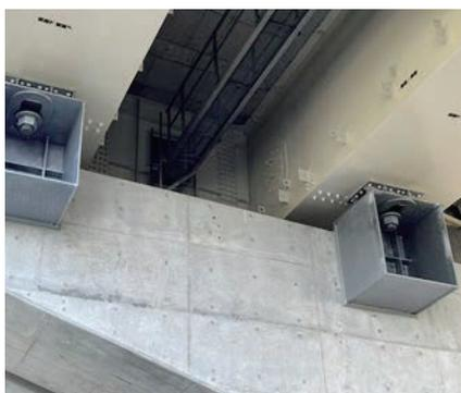
桁下型(箱桁)
