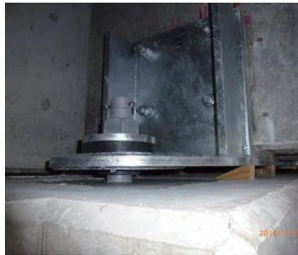
基本型(RC-T桁 縁端拡幅部設置)
