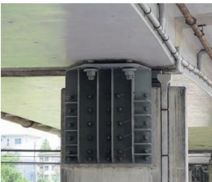
応用型(PC 箱桁設置)
