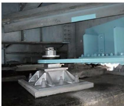
応用型(鋼桁橋羽根連結板-鋼製架台)
