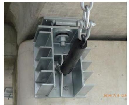
桁下型(RC 中空床版橋-落橋防止構造兼用)
