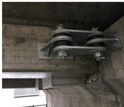
連結型(RC 桁-変位制限構造)
