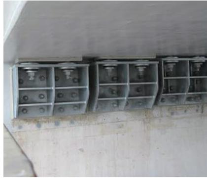
桁下型(鋼製架台2本設置)
