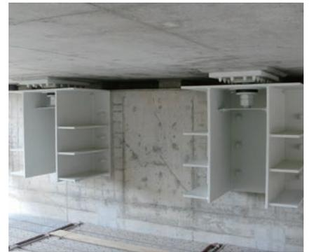
桁下型(Al-Mg溶射、Wナット仕様)
